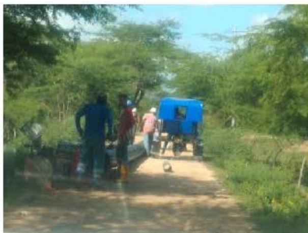
Foto 3. Obstrucción del paso vehicular debido a la ejecución del proyecto de instalación de la tubería.
