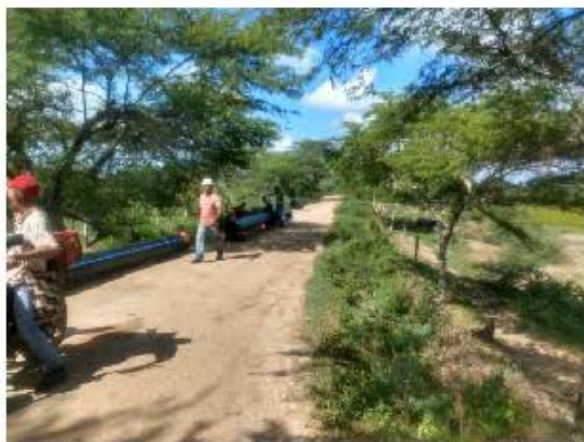
Foto 1. Parte de la tubería que se esta instalando.
