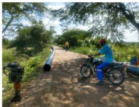
Foto 2. Parte de la tubería que se esta instalando
